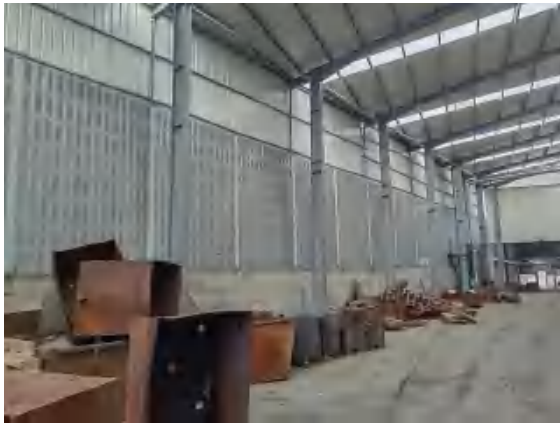
厂区西侧隔音墙
