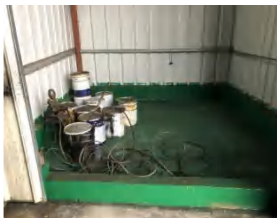
油漆、稀释剂暂存区围堰及防腐防渗
