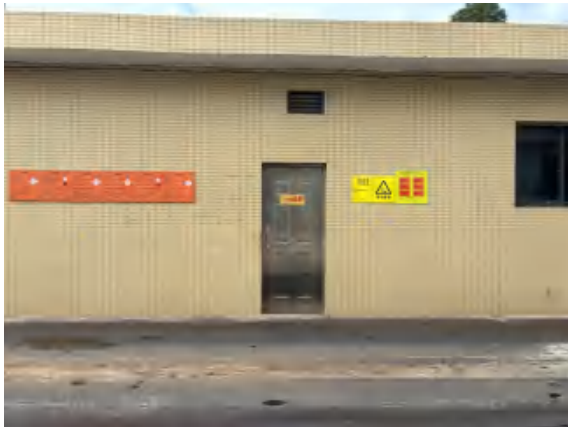
危废暂存间外部图
