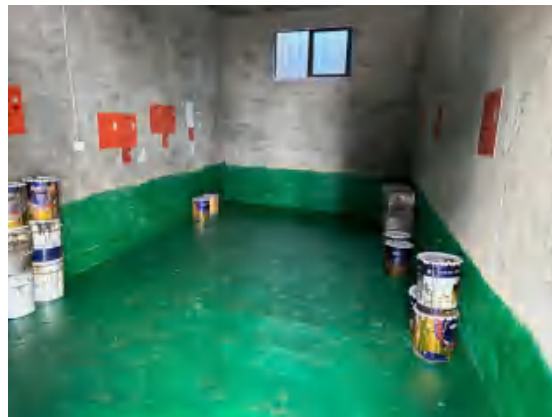
危废暂存间内部图
