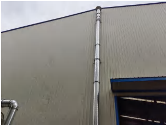
15m 排气筒 (DA008) (泡漆工序)
