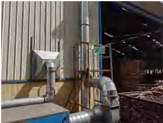
采样平台 (泡漆工序)
