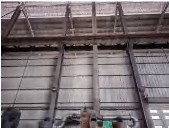
排放口标识牌，15m 排气筒（DA003） （3#抛丸机）
