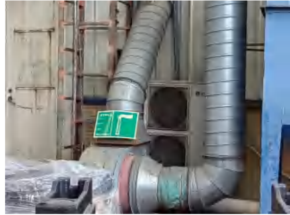
排放口标识牌（混砂工序）
