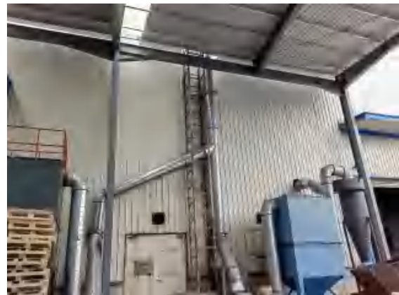
旋风除尘+袋式除尘器
