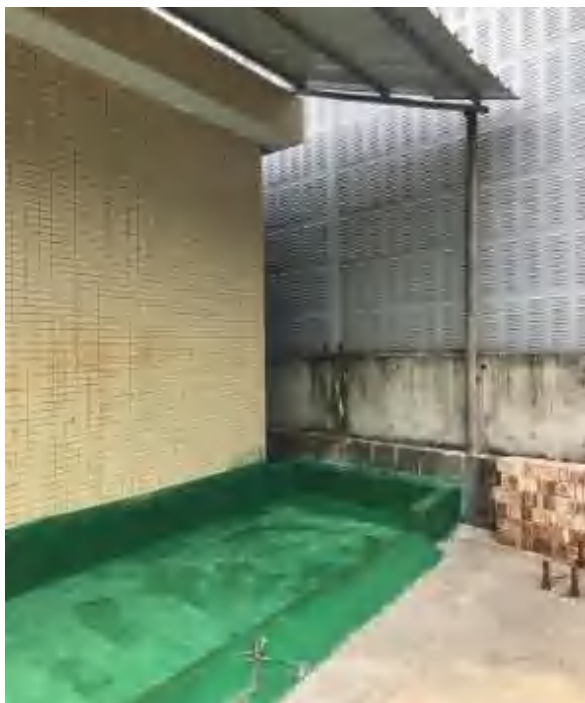
液压油、水溶性灭火液暂存区围堰及防腐防渗
